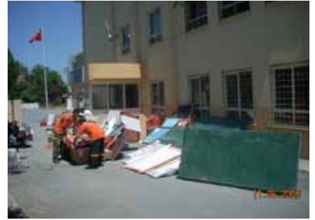
Hoşdere İ.Ö.Okulu tadilat çalışmaları
