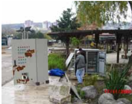
Elektrik panoları bakım ve onarım çalışması
