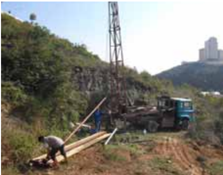
Su kuyusu bakım ve onarım çalışması
