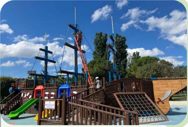
Resim 65 Aydınlatma Bakım Onarım Çalışması
