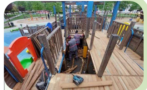
Resim 69 Ahşap Zemin Yenileme ve Boya Çalışması
