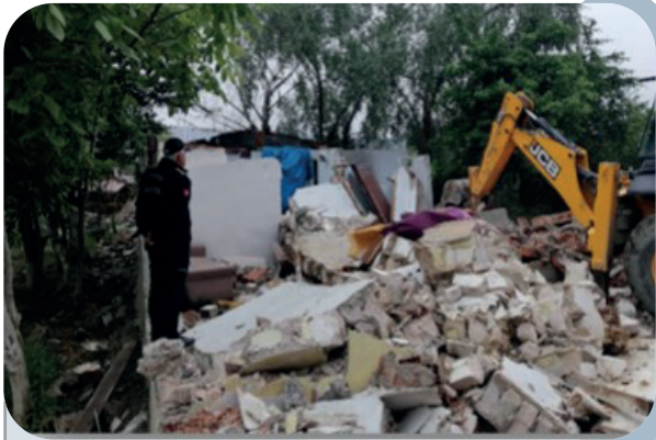
Resim 3 Metruk Yapı Yıkımı
