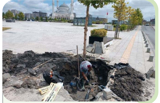
Resim 66 Enerji Besleme Kablo Onarım çalışması
